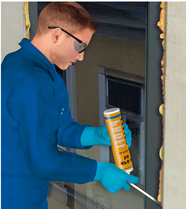
Abb. 5: Anwendung von PU-Schaum beim Fenstereinbau
