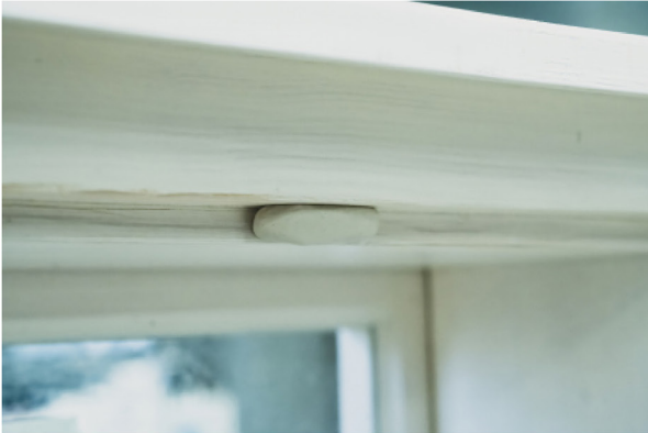
1. Knetdichtung anbringen
