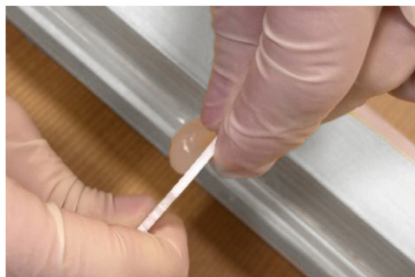
4. Abziehen mit Profil (Ansicht von oben)
