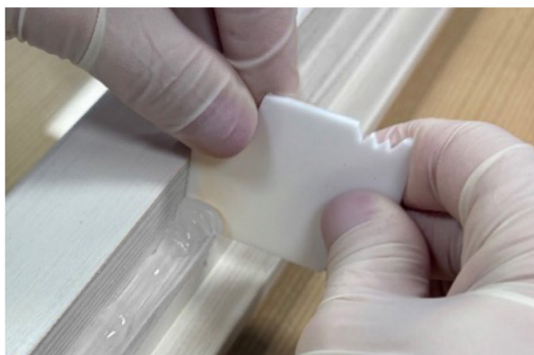
3. Abziehen mit Profil (Ansicht von vorne)
